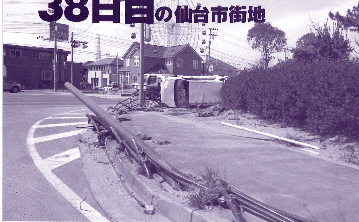
仙台港付近／津波で流れの方向にガードレールがなぎ倒されている。
