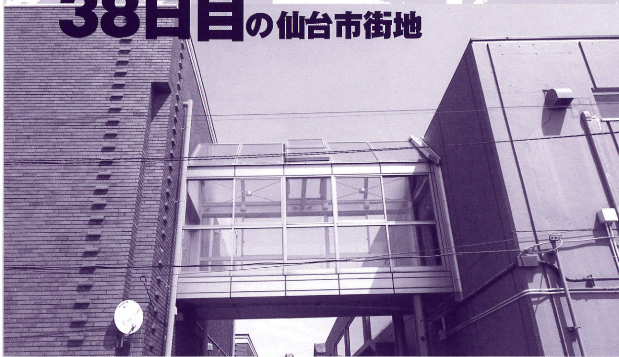
仙台市宮城野区扇町5丁目付近／エキスパンションの破損箇所が見える。
