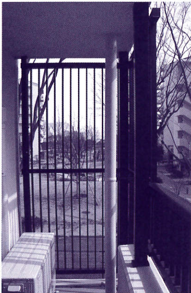
B棟 バルコニー側 手摺
