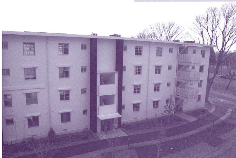
B棟 裏側 外観
