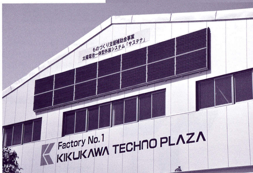
サステナ：試験的に壁面に取り付けられたサステナ。南面と東面に取付け、発電量の差を見ている。
