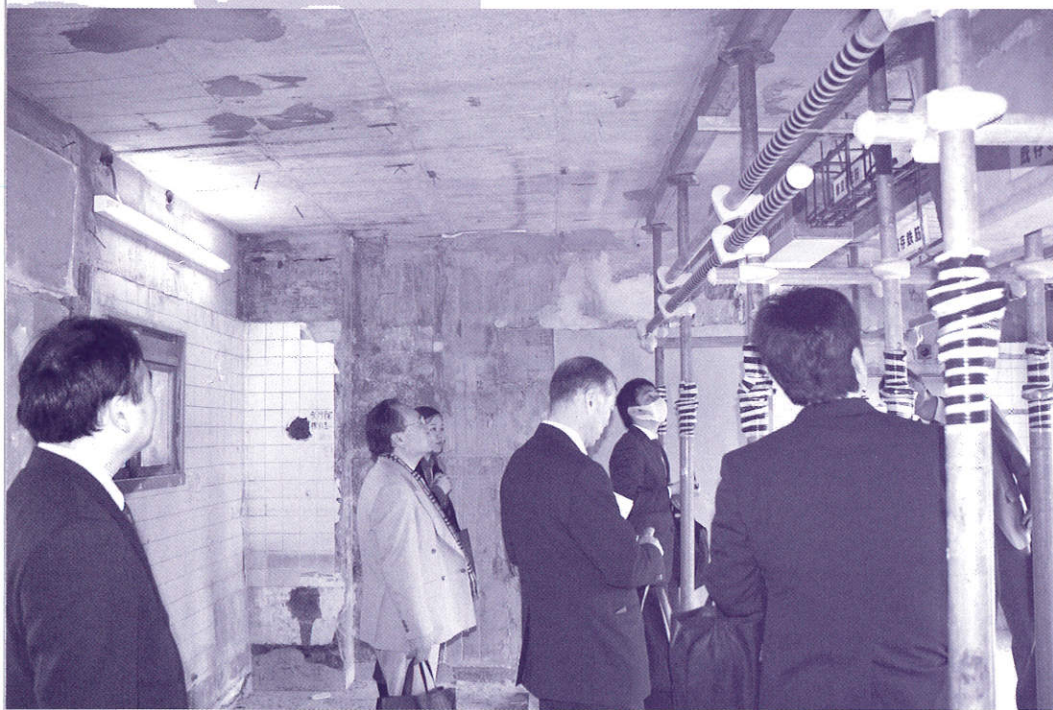
A棟 404号 工事技術の紹介
