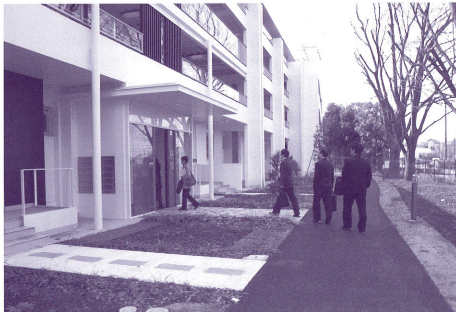
階段室を撤去しエレベーター設置
