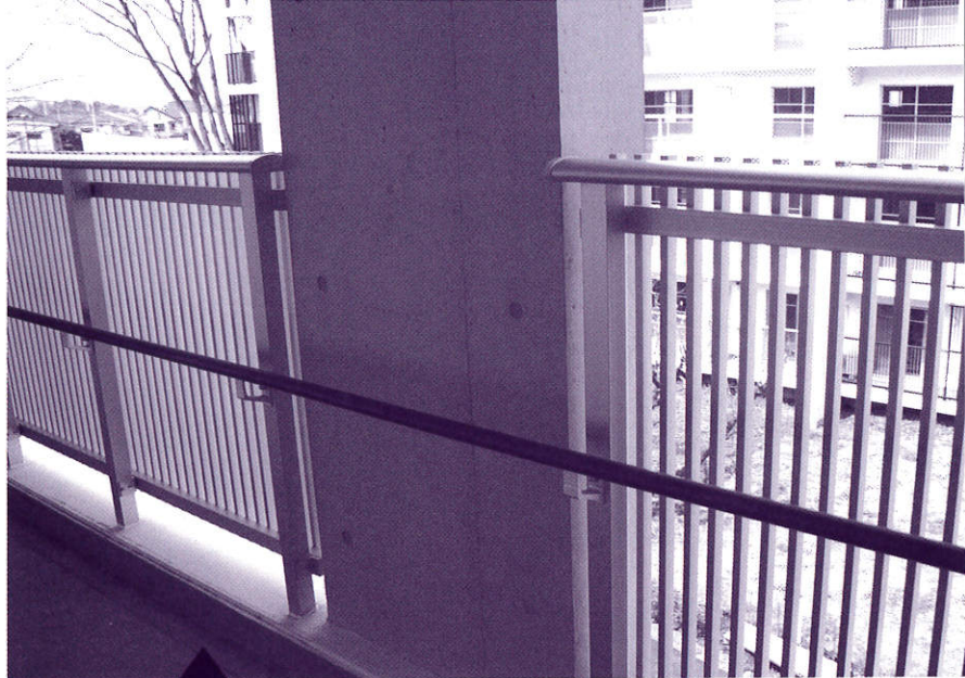
C棟 廊下 手摺
