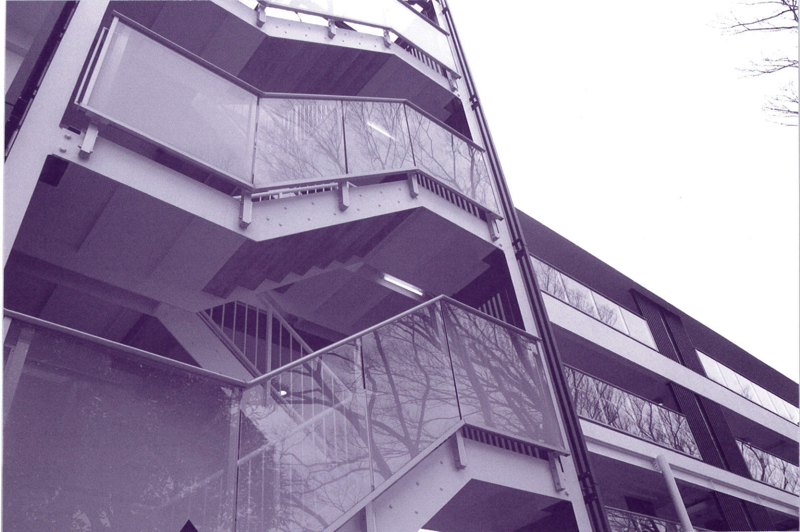
外廊下新設部分に施工された階段
