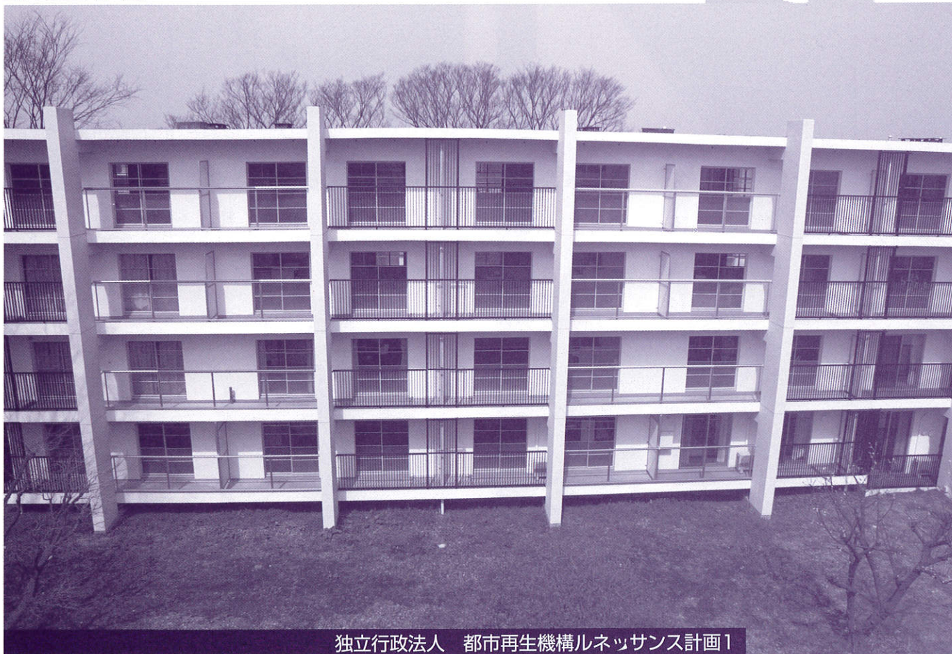
B棟 バルコニー側 外観
