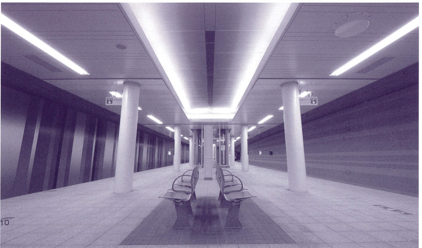
シンボリックなデザインの桜川駅上屋と、地下2階プラットフォーム
