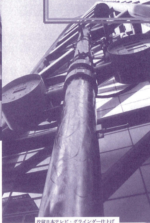
沙留日本テレビ: グラインダー仕上げ
