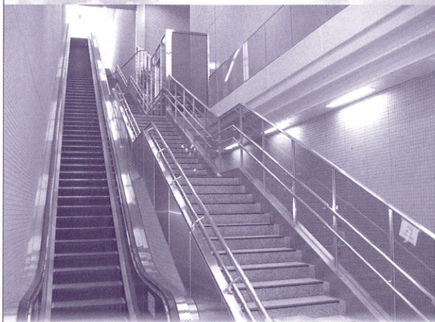
古市駅 階段手摺及びパネル
