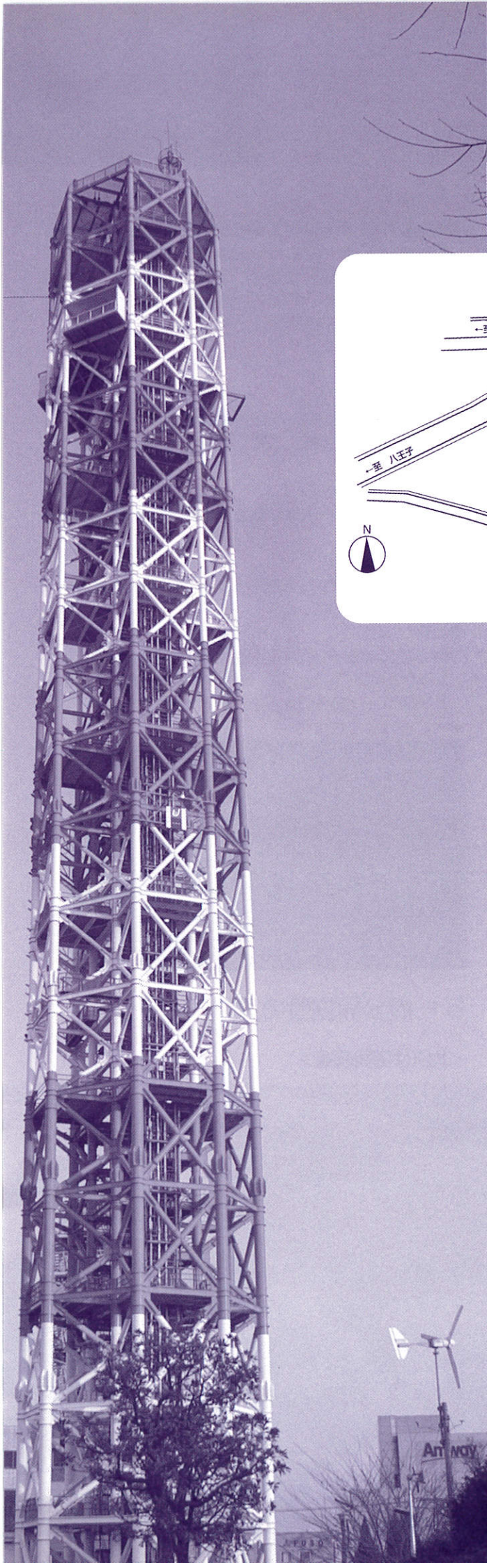
◀超高層住宅実験タワー 構造：鉄骨造、高さ：108m、平面：13m×13m
